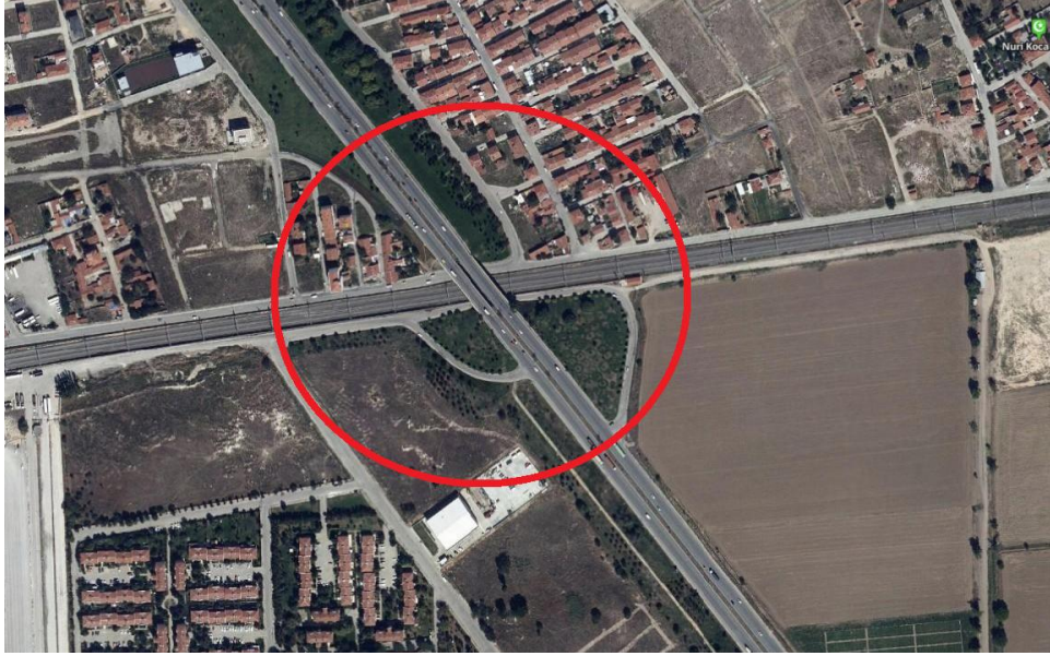
Uydu Görüntüsü-6: Şeker - Fevziçakmak Mahallesiinde Bulunan Demiryolu Üstündeki KGM Köprüsü,
