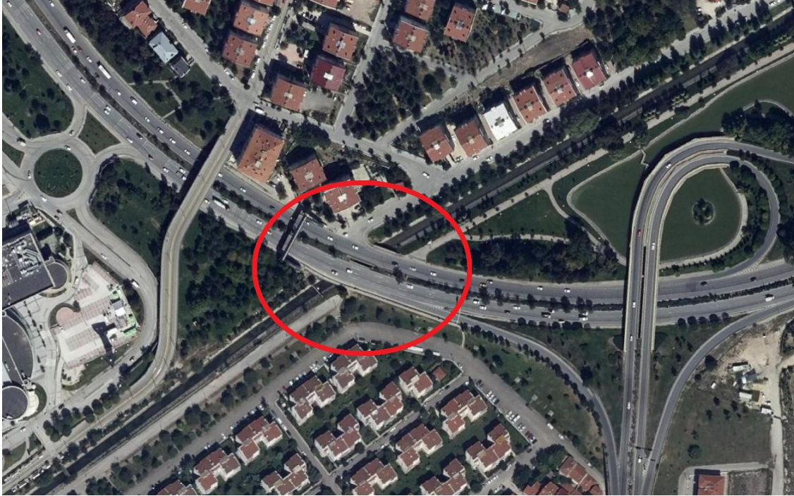
Uydu Görüntüsü-7: Uluönder Mahallesi, DSİ Kanalı üzerindeki KGM Köprüsü
