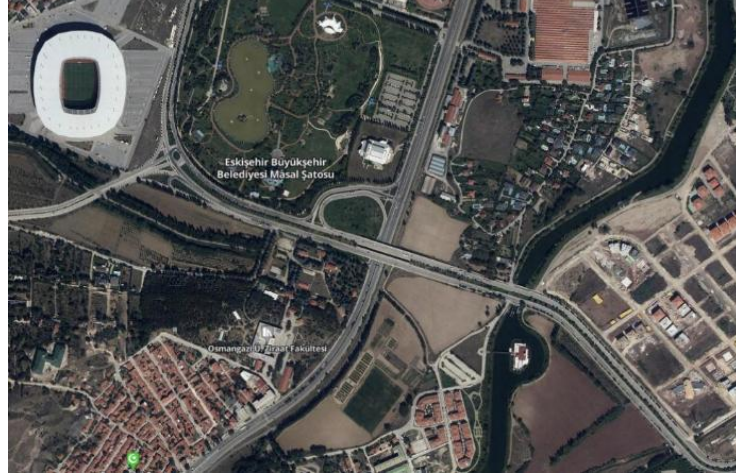
Uydu Görüntüsü-4: Mevcut Sazova Karayolu KöprülÜ Kavşağı
